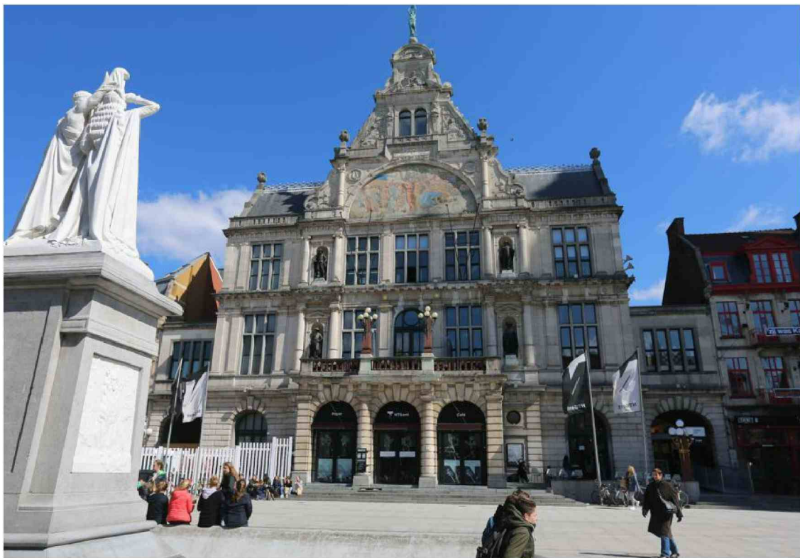
De gevel van NTGent heeft dringend een renovatie nodig (archieffbeeld). © FWV
