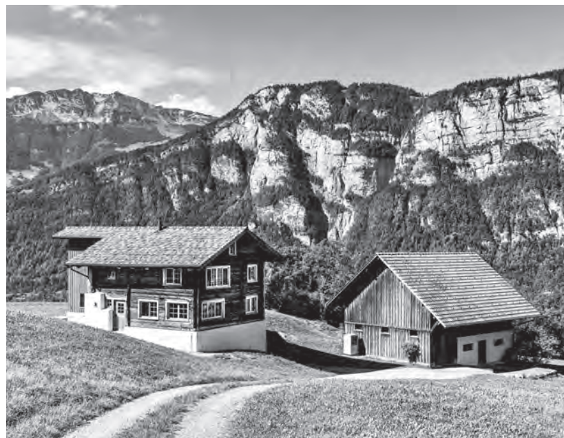
Beim Umbau «Schöfzig» wurde ein Strickbau aus dem Jahr 1778 in seinem Ausdruck erhalten. Die Dämmung wichtiger Bauteile kann die thermischen Schwächen alter Konstruktionen hinreichend kompensieren.
